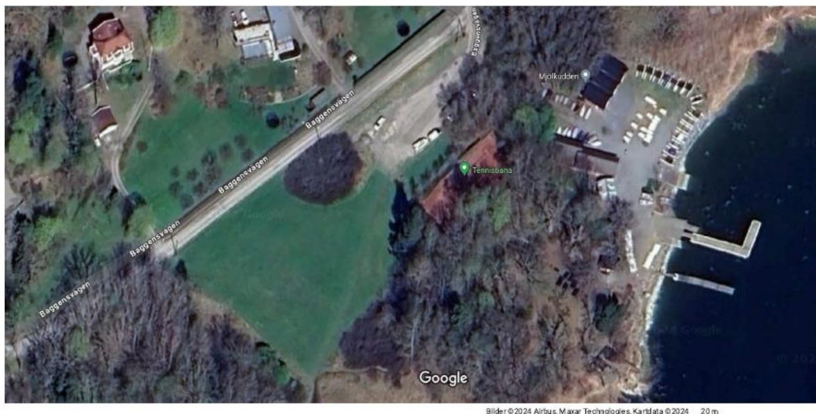
Bild 7. Översiktskarta från underlag för tidigare ärende B 2024-000694 Tidsbegränsat lov för byggbodas och upplag till och med 2029-05-10. Befintligt slånbuskage cirka 600 kvadratmeter stort syns intill Baggensvägen strax väster om parkeringen.
